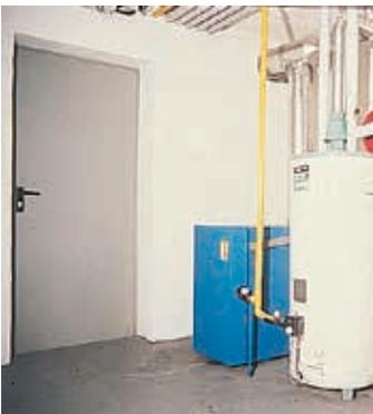
Alle Türen von Heizräumen müssen in Fluchrichtung aufschlagen und selbsttätig schließen. Türen, die nicht direkt ins Freie führen, müssen mindestens feuerhemmend sein.
