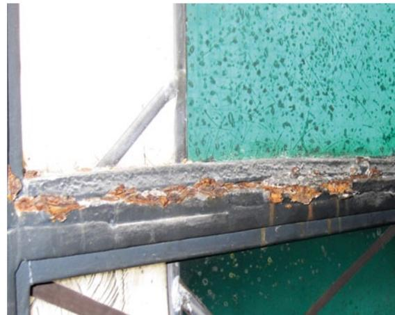
Durch Rost verformte Rahmenleiste eines Fensterfeldes
