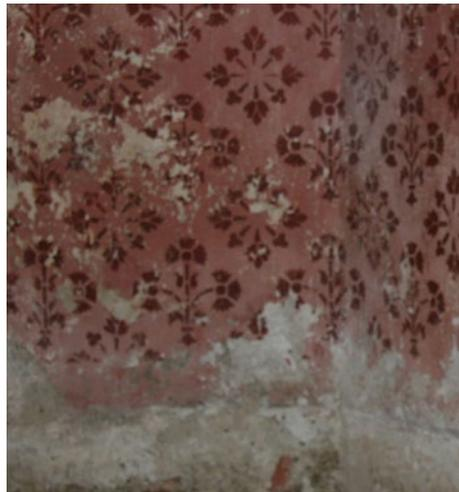
Durch aufsteigende Feuchtigkeit im Mauerwerk sind bodennahe Wandmalereien besonders gefährdet
