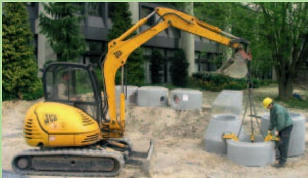
Der Anschläger trägt Schutzhandschuhe, Sicherheitsschuhe und Schutzhelm. Er hält stets Sichtkontakt zum Maschinenführer und tritt nur nach dessen Zustimmung in den Arbeitsbereich. Die Last wird nur bei Stillstand der Arbeitseinrichtung angeschlagen.
