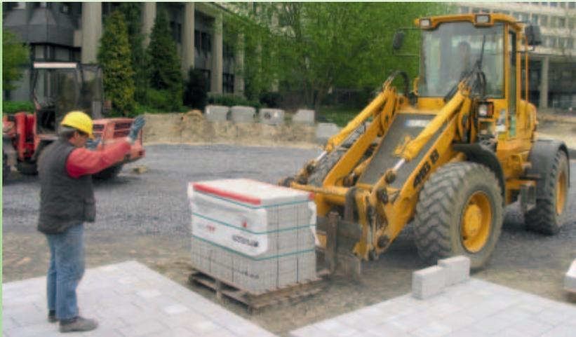
Vor der Inbetriebnahme der Erdbaumaschine werden die Spiegel so eingestellt, dass eine freie Sicht zu den Seiten und nach hinten möglich ist. Alle Scheiben müssen sauber, beschlag- und eisfrei sein.
