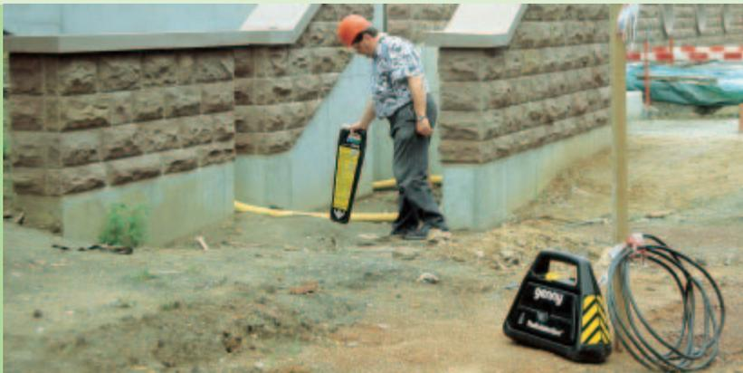
Im Einzelfall besteht daher die Pflicht, die genaue Tiefe und Lage durch Suchschlitze oder Ortungsgeräte festzustellen und den Verlauf zu kennzeichnen. Die Mitarbeiter sind vor Ort zu unterweisen. Im Bereich von Versorgungsleitungen dürfen Baumaschinen nur so eingesetzt werden, dass eine Gefährdung der Leitungen ausgeschlossen ist. In solchen Fällen sind Handschachtungen vorzunehmen.
